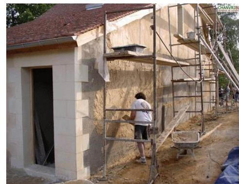
Mise en œuvre d'enduits sable et chaux sur une isolation extérieure en bloc de chanvre d'un mur en brique de terre cuite
