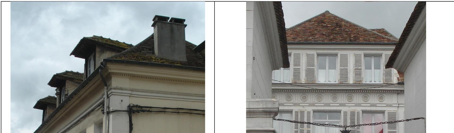
*Des bandeaux d'encadrement soulignent les ouvertures tout en affirmant la proportion entre pleins et vides. Ces bandeaux, d'une largeur de l'ordre de 18 cm, sont soit en légère saillie sur le nu du mur (de l'ordre de 2 cm), soit dans le plan de l'enduit et dessinés uniquement par une différence de finition (lissé sur enduit gratté)*
