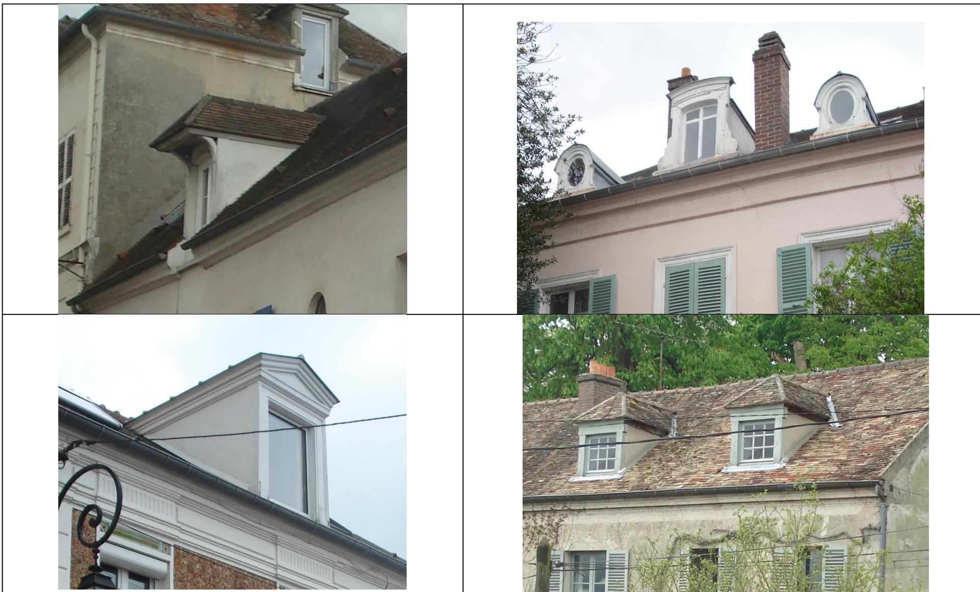
*Le 19<sup>e</sup> siècle a utilisé la lucarne à fronton, réalisé en charpente avec linteau droit ou cintré, ou habillé de zinc sur les constructions bourgeoises.*
