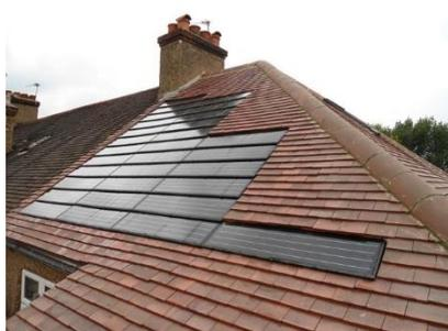
Tuile photovoltaïque sur toit de tuile plate en terre cuite
