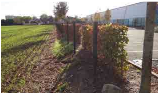
35 barrières arrachées sur la palissade située sur le côté est du parking des tennis.
